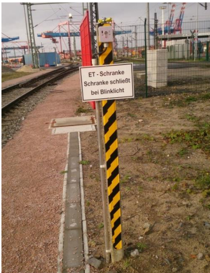
Abbildung 6 - HET für Bahnübergang Modul 2
